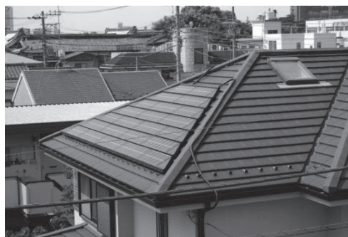
太陽光発電設備
