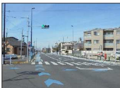
部分開通した補助 230 号線
