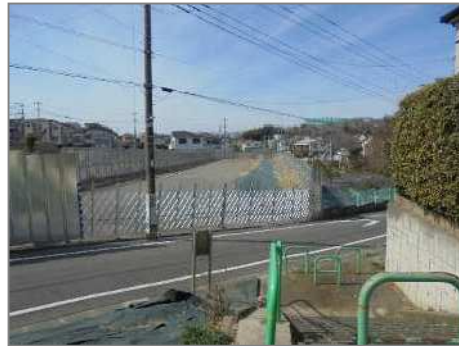
補助230号線 整備中区間
