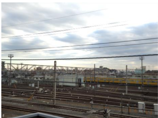
▲ 車両留置施設
