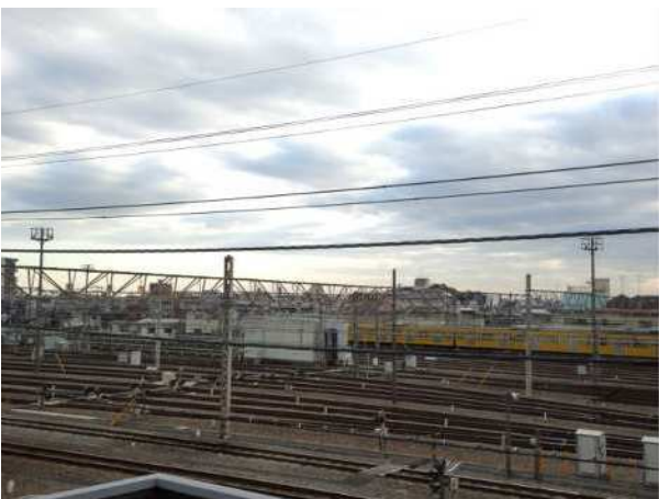
▲ 車両留置施設
