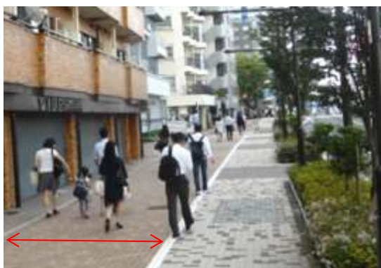
歩道有効幅員約3.5m
