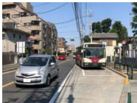
図 3-9 バス停留所（バスベイ）の設置例
