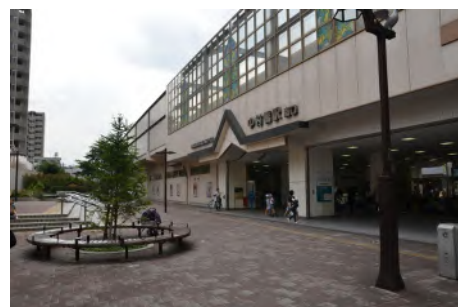
バリアフリー化された駅前広場の例 (西武池袋線中村橋駅)
