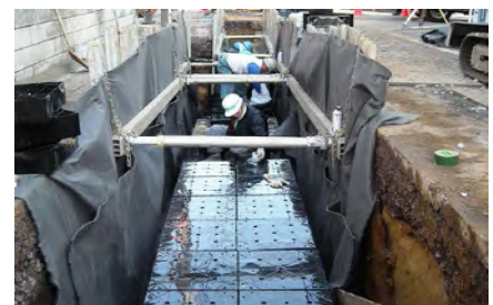
雨水貯留浸透施設設置工事（出典：練馬区資料）
