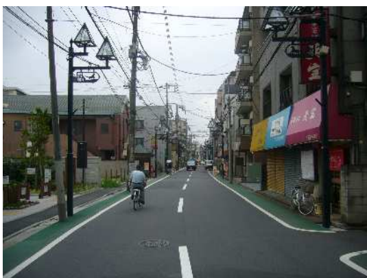
地区施設（生活幹線道路1号）
