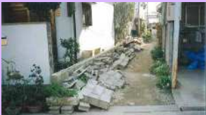
倒壊したブロック塀(資料写真)
