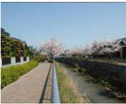
根ヶ原橋下流付近
