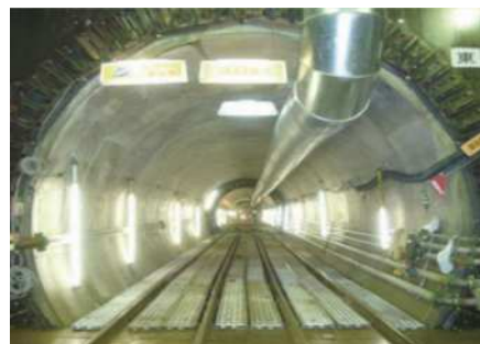
中村・豊玉北地区の雨水貯留管整備状況 （下水道） （出典：練馬区総合治水計画）
