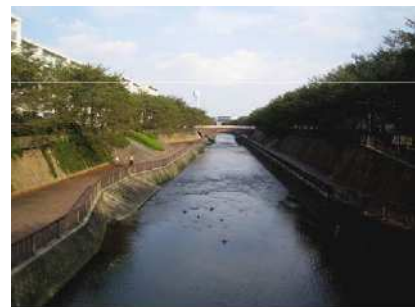
石神井川緩傾斜護岸 (出典：練馬区みどりの基本計画)
