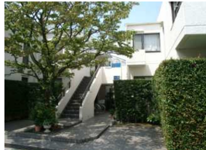
エントランスに みどりを配置した建物
