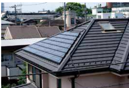
太陽光発電設備
