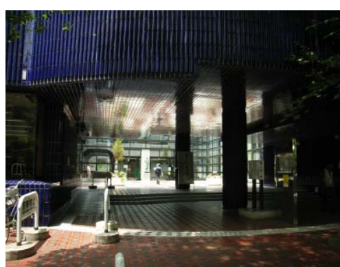
エントランスに小広場を設けるとともに、建物中央に中庭を設けるなど人が滞留できる空間を確保するよう建物を配置している例。 (練馬公民館・練馬図書館)
