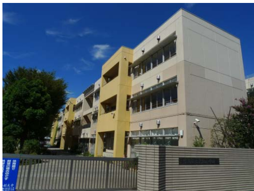
建物の形状に合わせてアクセント的に色彩の工夫をしている例。(光和小学校)
