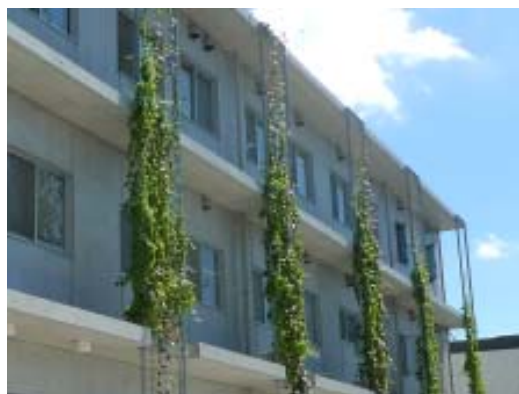
ツタをはわせた例。 (練馬区資源循環センター)
