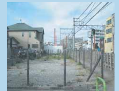
2号線環8東側：用地取得後 (平成18年度完成予定)
