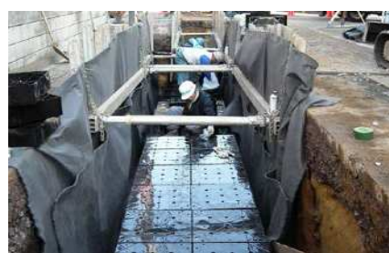
雨水貯留浸透施設設置工事（出典：練馬区資料）
