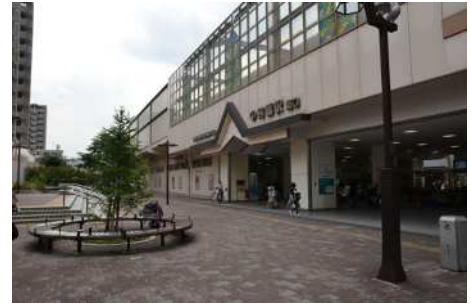
バリアフリー化された駅前広場の例 (西武池袋線中村橋駅)
