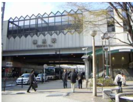
千川通りから見る練馬駅
