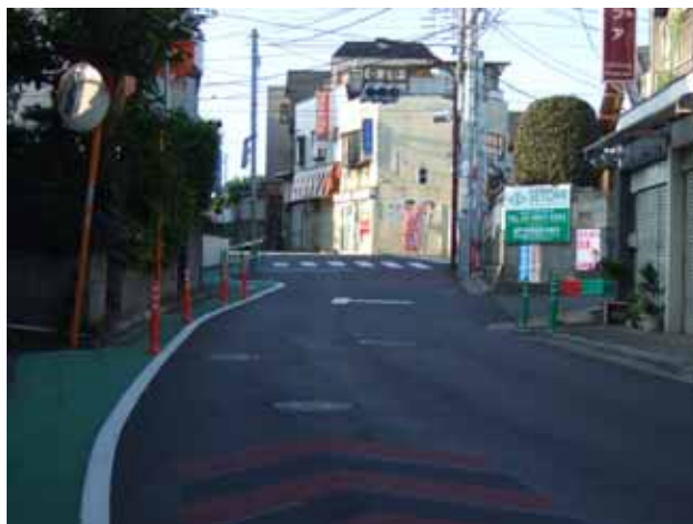
図 安全対策の実施例（カラー舗装による歩行者通行帯の明示・ポストコーン設置）
