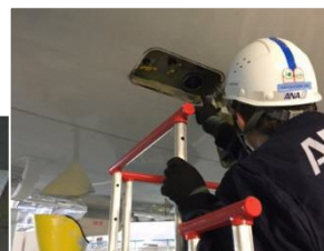
ヒーター付き水排出管
