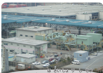
粗大ごみ破碎処理施設
