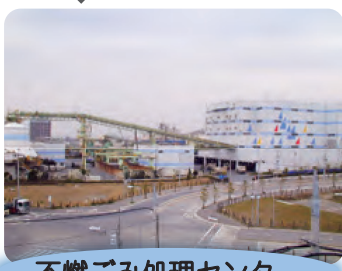
不燃ごみ処理センター
