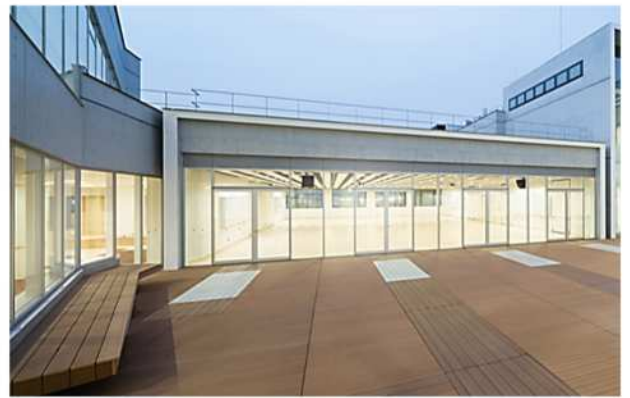
▲校舎屋上【豊玉第二中学校】
