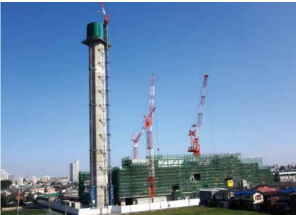
建設工事の全景(練馬清掃工場)
