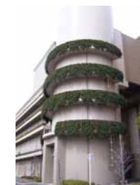
煙突の壁面緑化 （多摩川清掃工場）
