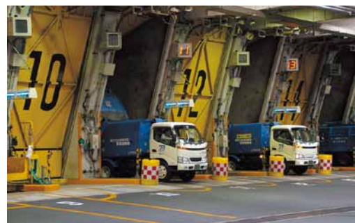
ごみの搬入の様子（足立清掃工場）
