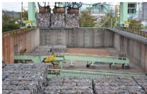
鉄分貯留ヤード（中防不燃ごみ処理センター）
