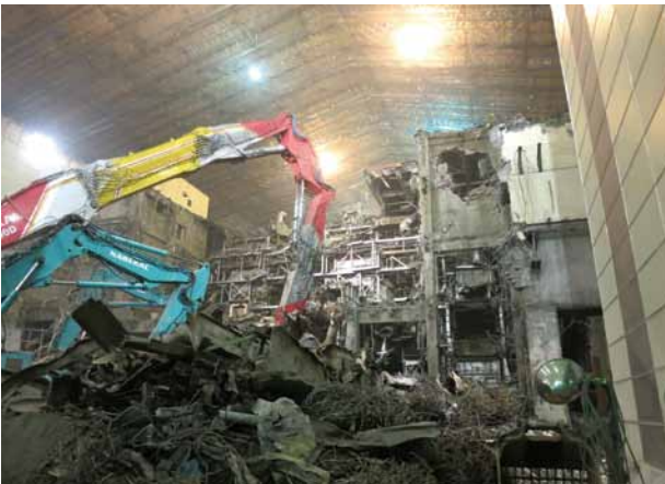
仮設テント内での解体工事(杉並清掃工場)
