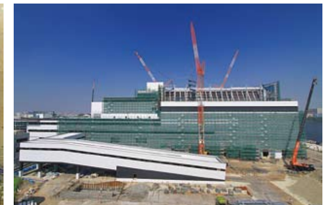
建設工事の全景（大田清掃工場）
