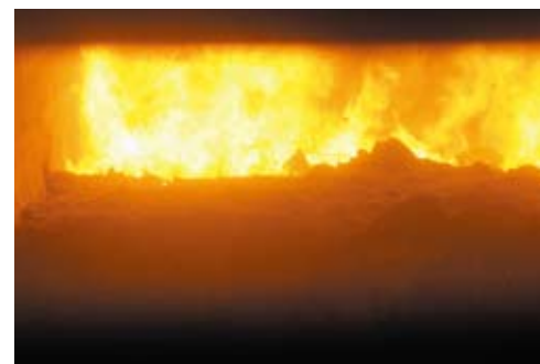
焼却炉内部の様子 (北清掃工場)
