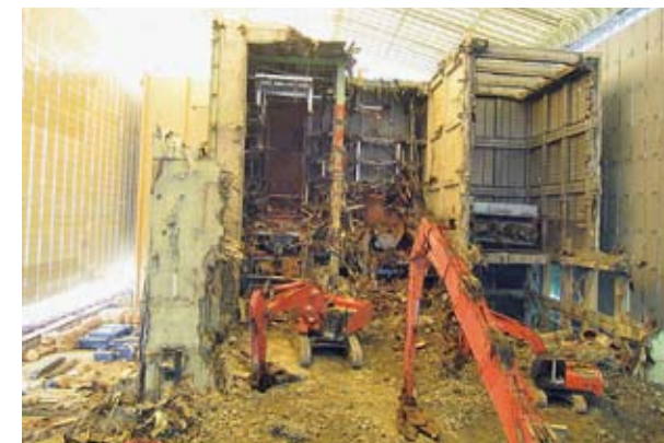
仮設テント内での解体工事（練馬清掃工場）
