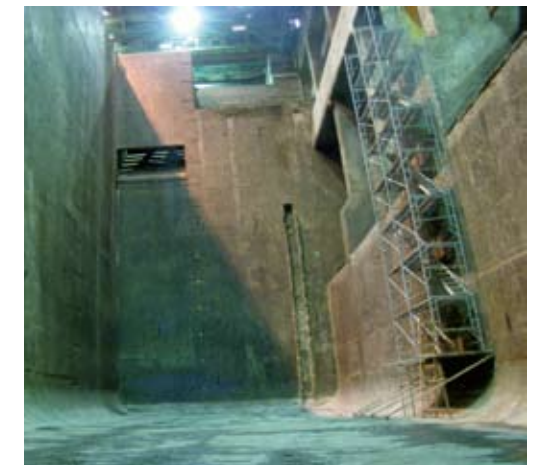
解体前清掃後のごみバンカ（杉並清掃工場）
