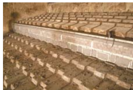
焼却炉の火格子 (新江東清掃工場)
