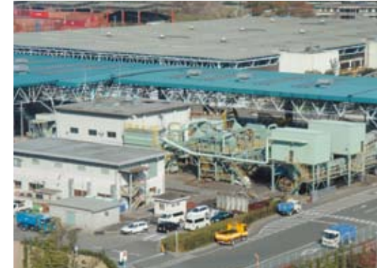
粗大ごみ破碎処理施設
