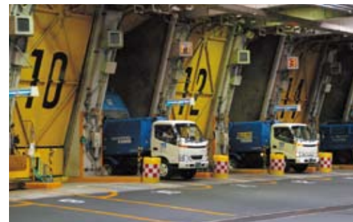
ごみの搬入の様子（足立清掃工場）
