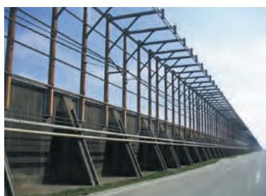
埋立地のごみが海に飛散しないよう、周囲にネットフェンスを設置しています。
