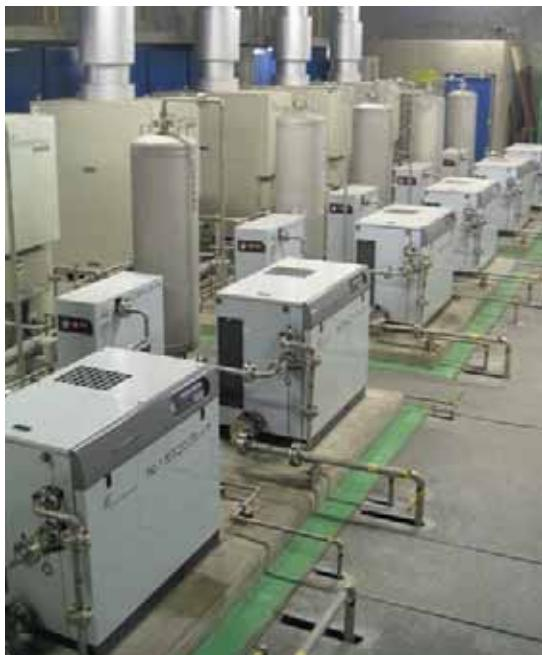
中央防波堤内側埋立地から発生するガスを燃料にして、発電を行います。エネルギーの有効利用とともに、温室効果の高いメタンガスが大気に放出されるのを防ぎます。
