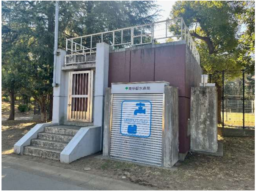
災害時給水ステーション
