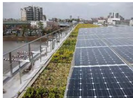
小学校への太陽光パネルの設置
