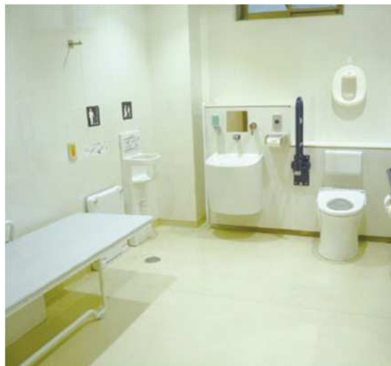
大型ベッド、オストメイト設備を設けた だれでもトイレの設置（図書館）
