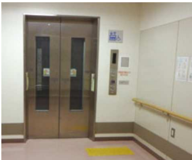
写真：区立施設の改修事例 ガラス窓付きエレベーターを設置（集会所）
