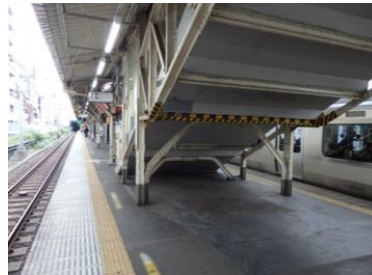
●視覚障害者が誤って階段裏の空間に踏み込み衝突する恐れがある事例。視覚障害者は白杖で前方の状況や障害物を確認し歩行するため、白杖での検知は足元が優先となる。このため、吊り看板や階段裏のスペース等、空中(頭部付近)の突出物に、誤って衝突してしまう可能性がある。
