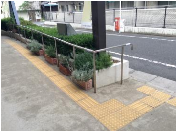
●視覚障害者誘導用ブロックと側壁の離隔が不十分な例。
