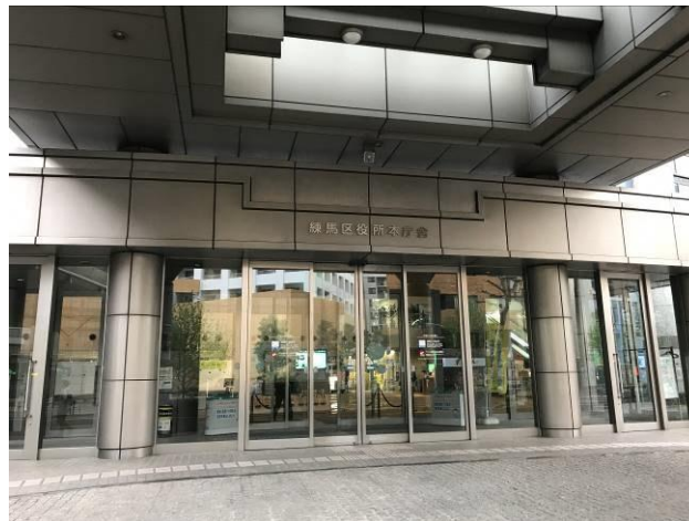
◎公共施設の出入口は十分な有効幅員を確保する。
