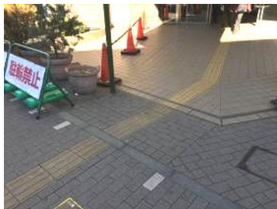
例) 駅から施設まで視覚障害者用誘導ブロックが連続的に敷設されている
