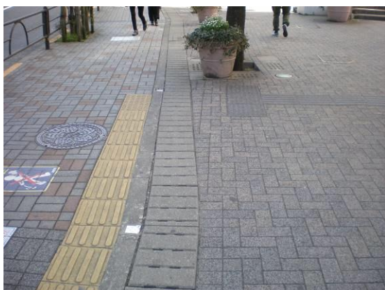
●【不連続の例】管理境界部で視覚障害者誘導用ブロックが分断されている。
