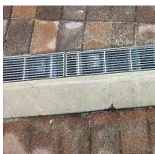
◎排水溝等は溝蓋を設け、溝の間隔は車いすの前輪や杖先が落ち込まないものとする。
