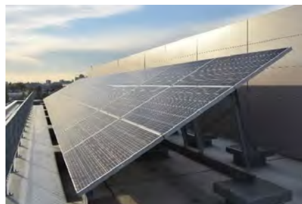
<太陽光発電設備（北保健相談所）>
