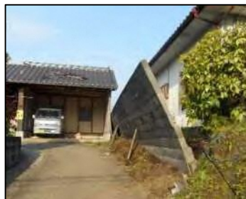
傾いたブロック塀 (平成 28 年熊本地震)
