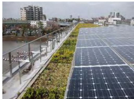
小学校への太陽光パネルの設置
