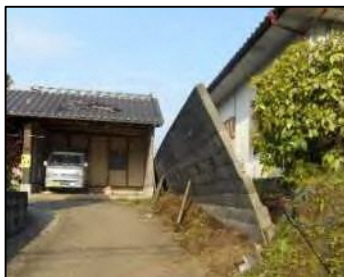
傾いたブロック塀 (平成28年熊本地震)
