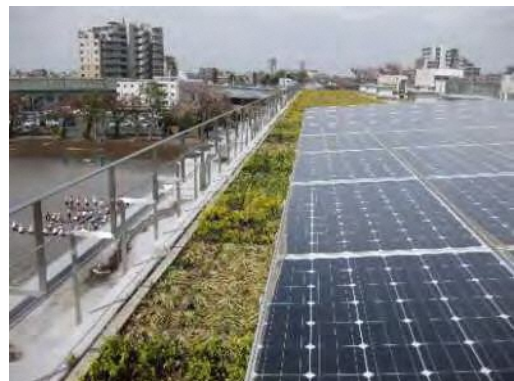
小学校への太陽光パネルの設置
