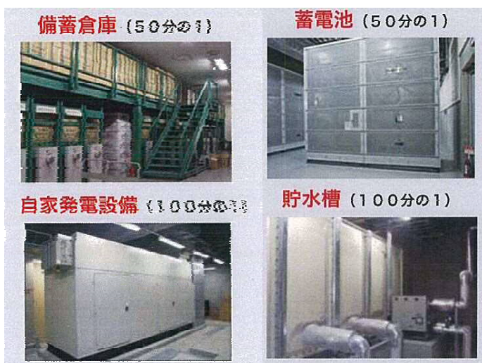
図4）防災・減災施設の例（国交省解説より）
