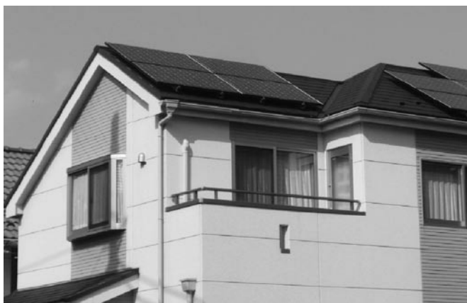
写真1 太陽光発電設備の例
