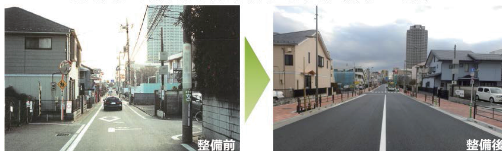
無電柱化により防災性や快適性が向上した道路（補助132号線）
