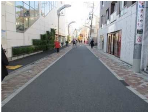
▲密集事業により整備した道路 (江古田北部地区)
