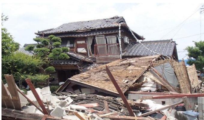
熊本地震の被害
