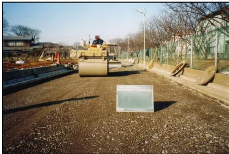
砂利を敷いて、ローラーなどの機械で固めます。
