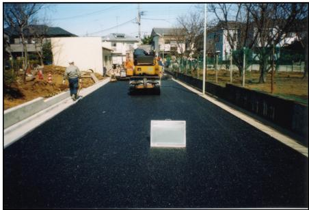
アスファルトを敷いて、ローラーなどの機械で固めます。
