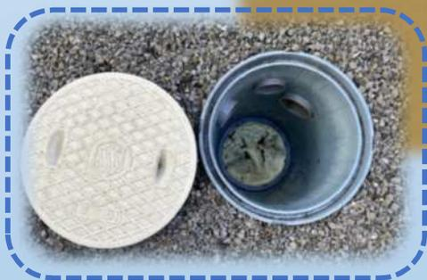
ご自宅にある浸透ますなどは大雨時に浸水被害を軽減させるために大切なものです
