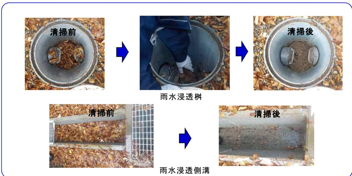
写真 3-5 雨水浸透施設 清掃前後の状況
