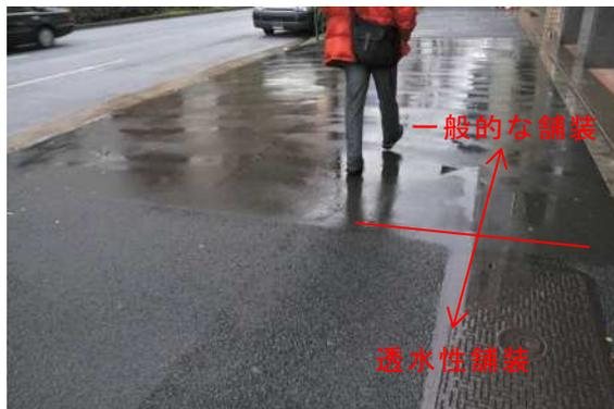
写真 3-3 透水性舗装施工例
