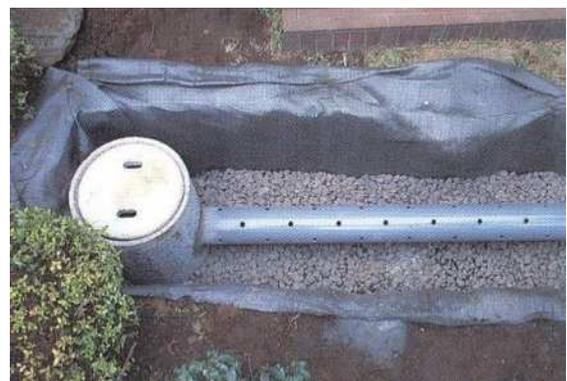
写真 3-4 浸透ます・浸透トレンチの設置例
