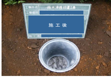
雨水浸透ます設置工事
