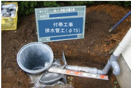
雨水浸透ます設置工事
