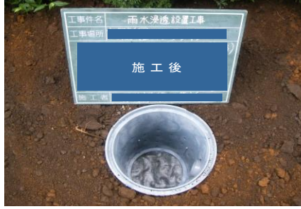
雨水浸透ます設置工事
