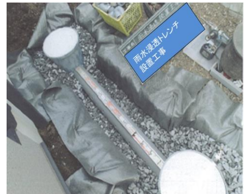
雨水浸透トレンチ設置工事
