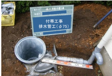
雨水浸透ます設置工事
