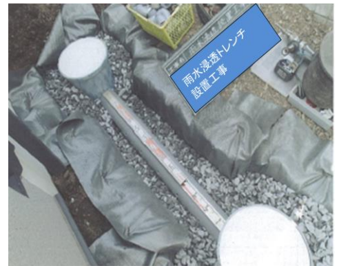
雨水浸透トレンチ設置工事
