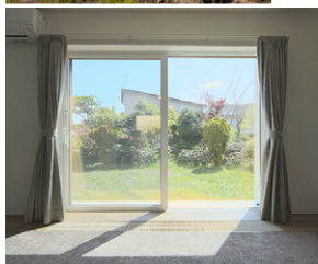
外窓交換（はつり工法）を実施
