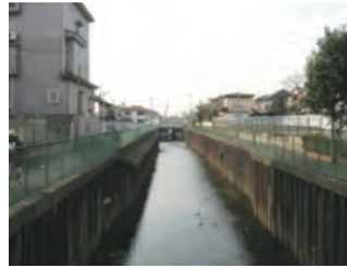
石神井川（護岸改修前）
