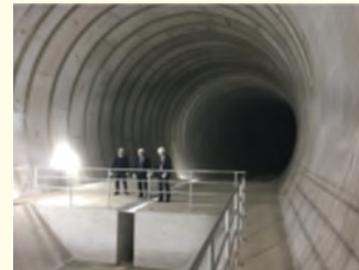
白子川地下調節池（容量：212,000m 3 ） 構造形式：地下トンネル式 台風 19 号による貯留率：約 9 割
