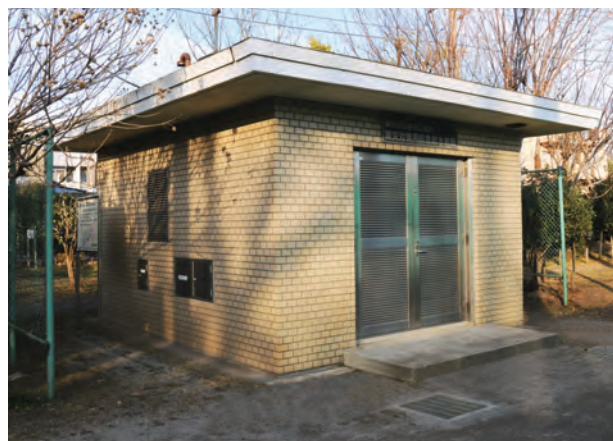
学田公園内の応急給水槽の管理施設 (地下に1,500m 3 の水槽があります)
