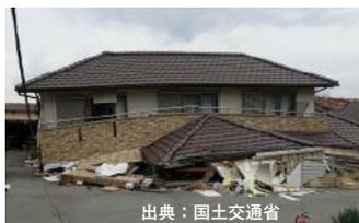
▲熊本地震で倒壊した新耐震基準木造住宅
