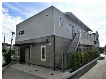
◀ 民間事業者が整備・運営する 重度障害者グループホーム 「おおいずみまちホーム」 (31年1月開設)
