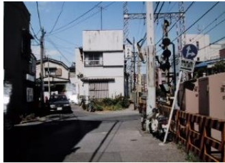
▲拡幅前の路線（北町）
