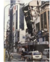
▲阪神淡路大震災による被災建築物
