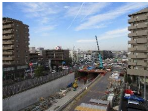
▲放射35号線 (平和台駅付近の立体交差部)
