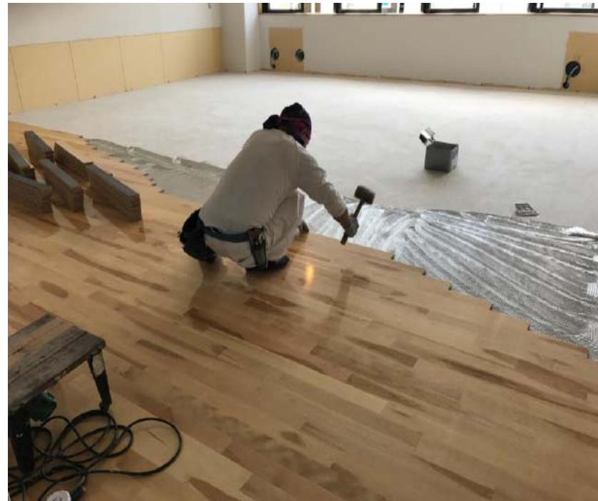
フローリング工事
