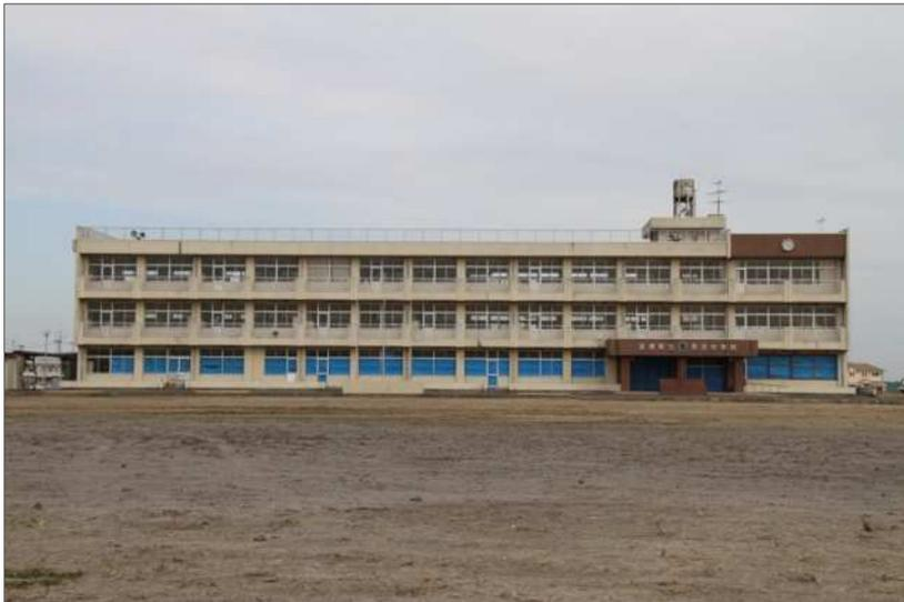
津波は、住宅街を押し流した。学校は倒壊をまぬがれたが、1階部分は波に抜かれた。1階の窓ガラスは全て無くなり、ブルーシートで応急処置をしている。
