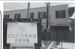
2階建て施設の2階部分です。
