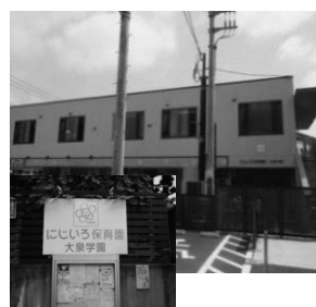
2階建て施設の2階部分です。
