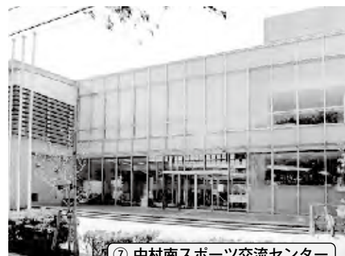
⑦ 中村南スポーツ交流センター
