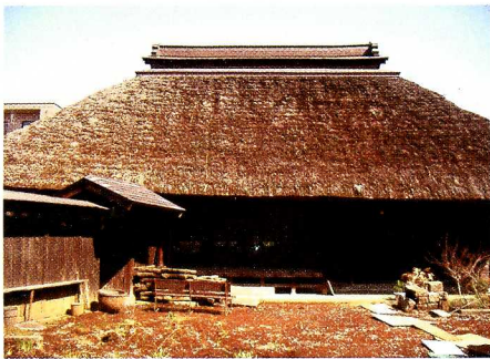
解体前の様子
