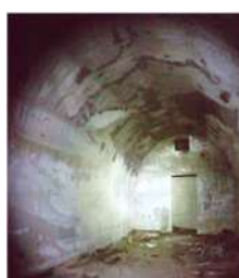
地下施設内部の様子
