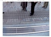
誘導ブロックが周囲と同系色で見分けにくく、排水溝により 途切れている。誘導ブロックの色は、弱視の方も判別しやす いように、周囲と見分けやすい色とし、建物の出入口まで連 続的に敷設することが重要である。
